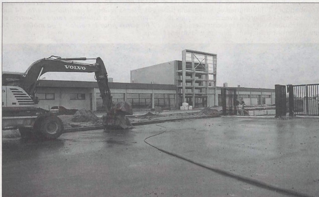
Le restaurant self-service est toujours en chantier à quelques semaines de l'ouverture. (Photos Andy Mekerke)
